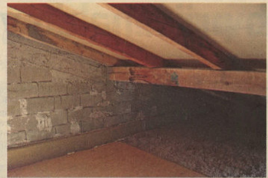
Pri dodatni toplotni izolaciji stavbe stanovalci bloka v Cerknici niso pozabili na izolacijo tlaka neogrevane podstrehe, kar se občutno pozna pri njihovih prihrankih stroškov za ogrevanje.
