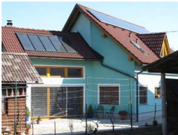
»Sončna hiša« izkorišča vse tri načine izrabe sončne energije: pasivno skozi stekla na južni strani, aktivno pa s SSE in fotovoltaiko.
