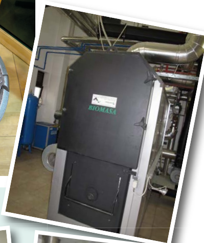
Na fotografiji je gorilnik za sekance ali pelete.
