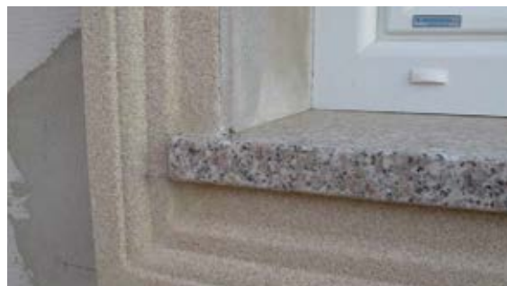
Detajl stika kamnite poličke in okrasne bordure okrog okenske odprtine.
