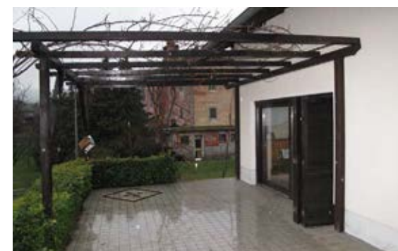
Pergola z olistano trto na južni strani senči stavbo poleti, medtem ko pozimi omogoča pasivno ogrevanje prostorov.
