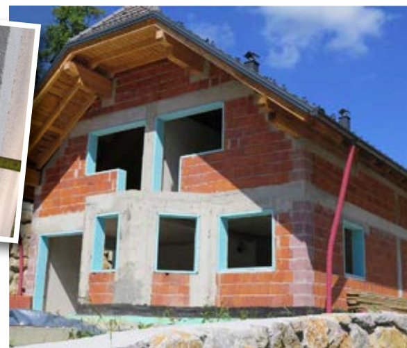
Toplotna izolacija odprtín pred vgradnjo oken in vrat je dobra rešitev, saj odpravi možnost nastanka toplotnih mostov.
