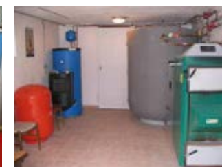
Sodobna kurilnica na polena. Desno je kotel, za njim HTV. V ozadju levo je modra toplotna črpalka zrak/voda. Zunaj kurilne sezone deluje samostojno, med ogrevalno sezono pa služi kot bojler za sanitarno vodo. Rdeča tlačna posoda pred njo omogoča izravnavanje tlakov, ki nastanejo z ogrevanjem in hlajenjem vode v ogrevalnem sistemu.
