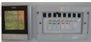
Centralna enota za nastavitve parametrov.
