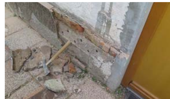
Vsaka celovita obnova se začne pri temeljih. To je najbolj celovit del stavbe, saj je treba rešiti (ali preveriti) statiko ter toplotno in hidroizolacijo.
