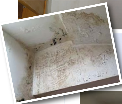
Tako je videti plesen v sanitarijah gostinskega lokala. Kljub očitnemu zamakanju – kar pomeni, da je vzrok težko odstraniti – je začasna odstranitev plesni preprost poseg.
