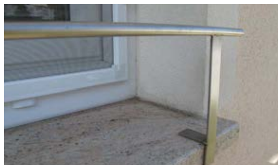
Zunanja kamnita polička pri oknu, montirana na zunanjo linijo zidu. Celotna polička leži na 15 cm toplotne izolaciji. Za ljubitelje rož je nujna zaščita (ograjica) za rože.
