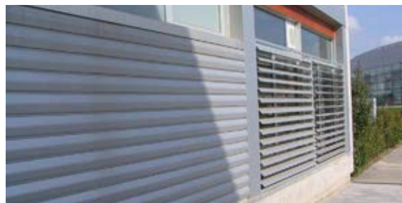
Zunanje žaluzije, imenovane »krpanke«, so lahko popolnoma zaprte ali odprte.
