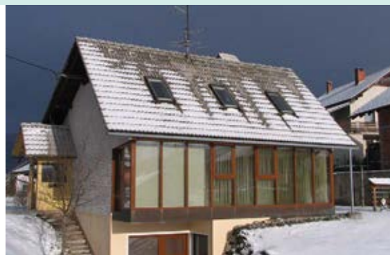
Zimski vrt je priljubljen element za pasivno izrabo sonca. Lahko je podaljšek stavbe (levo) ali pa je integriran v stavbo (desno). V obeh primerih je treba zagotoviti kakovostna senčila, ki preprečijo poletno pregrevanje.
