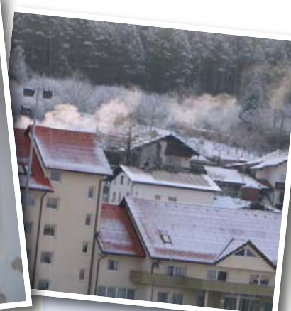
Slabo izvedene detajle pri strehi odkrije sneg.
