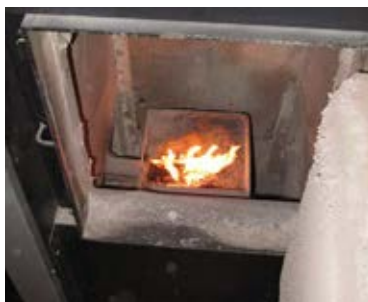
Tako gorijo peleti v kotlu z močjo 15 kW.
