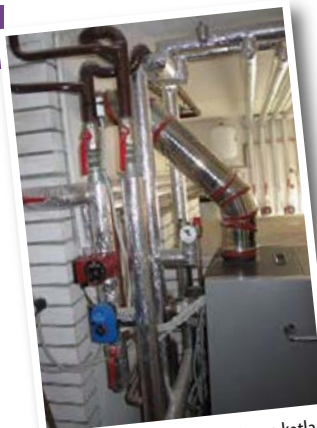
Vzorno izoliran razvodni sistem kotla na polena.
