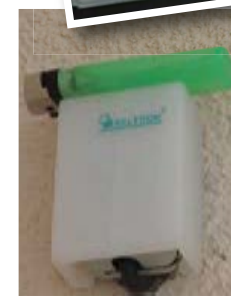
Zunanje tipalo ogrevalnega sistema.
