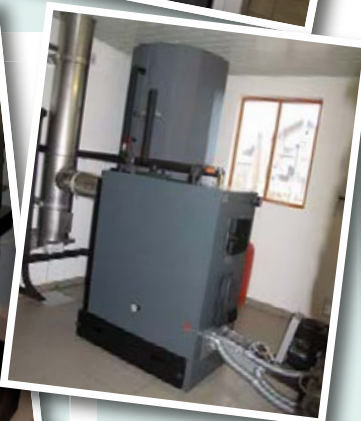
Kotel na sekance (120 kW), zadaj hranilnik tople vode (2000 l), desno povezava polža in kotla z regulatorjem primarnega in sekundarnega zraka.
