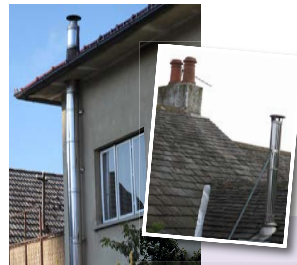
Vedno bolj se uveljavljajo kovinski dimniki. So lahkši, cenejši, učinkovitejši, lažje jih je montirati, imajo boljši vlek in so bolj odporni proti kislinam ter drugim obremenitvam.
