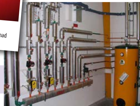
Primer učinkovite razpeljave in kakovostne izolacije cevi.
