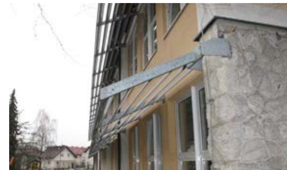
Senčilo nad šolskimi okni ne zapira pogledov ven, soncu pa onemogoča dostop do stekla in s tem preprečuje pregrevanje učilnic.
