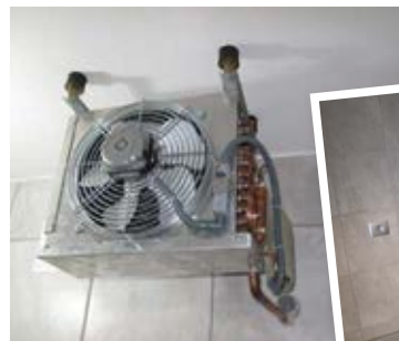
Uparjalnik TČ je v kleti, da jo z odvzemanjem toplote ohlaja.
