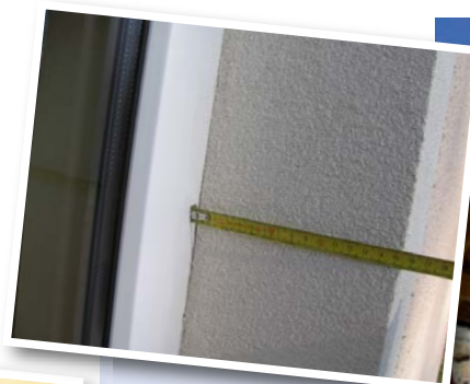
Leta 2004 je bila 15 cm debela izolacija na fasadi še nenavadna, danes postaja 20 cm standard. S fotografije je razvidno, da so okna vgrajena na zunanjo linijo zidu, celotna špaleta je tako iz toplotne izolacije.
