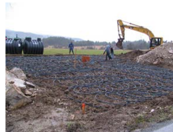
Spiralno zvite cevi zemeljskega kolektorja na plasti zemlje pred zasipanjem.
