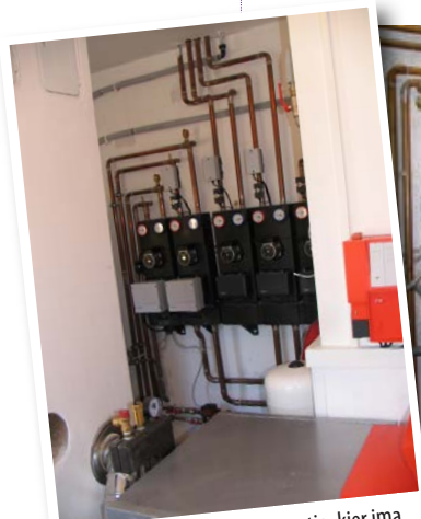
Razvodni sistem talnega gretja, kjer ima vsaka razdelilna omarica svoj neodvisen sistem črpalk in regulacije.
