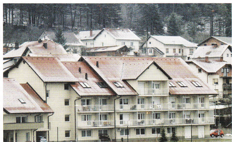
Neustrezno izolacijo podstrešja ali nedosledno izvedbo toplotnoizolacijskega ovoja je pozimi težko skriti. Na fotografiji je od 11 stavb le ena kvalitetno toplotno izolirana.
