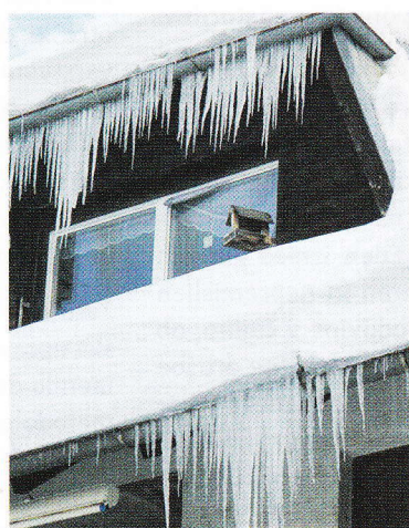
Neustrezno izolacijo podstrešja ali nedosledno izvedbo toplotnoizolacijskega ovoja je pozimi težko skriti. Na fotografiji je od 11 stavb le ena kvalitetno toplotno izolirana.
