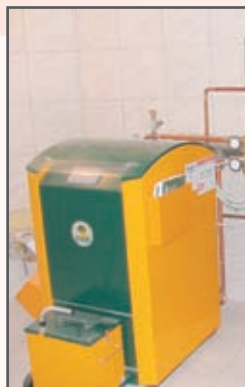
Majhen in učinkovit sistem, pred kotlom je posoda za pepel (avtomatsko polnjenje)
