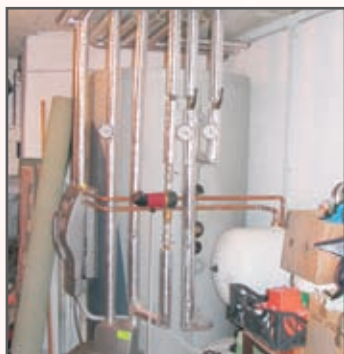
Hranilnik tople vode 1000 litrov, levo je komandni set, spodaj je prenosnik toplote
