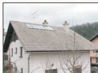
9 m 2 ploščatih SSE (samogradnja), montiranih v streho
