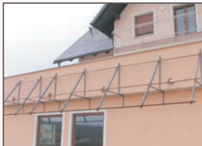
Kovinska konstrukcija (še čaka montažo 15 m 2 SSE) bo hkrati nadstrešek
