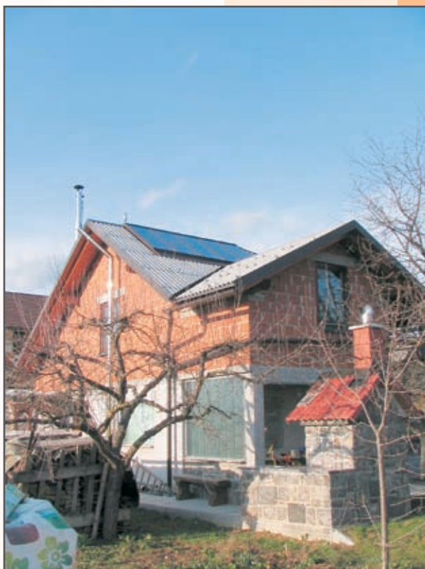
SSE na strehi kurilnice in zunanji kovinski dimnik
