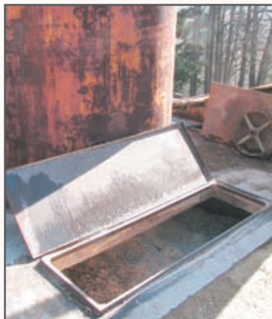
Skladišče za sekance je pod zemljo, zadaj silos za žaganje iz mizarske delavnice
