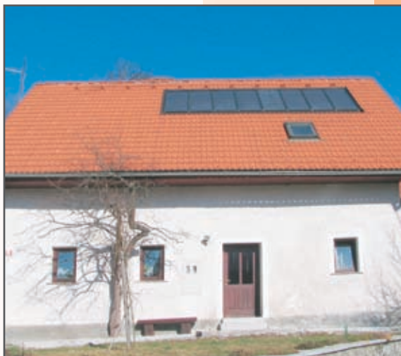
Sončna lega hiše kar kliče po instalaciji SSE, ki so en vir energije
