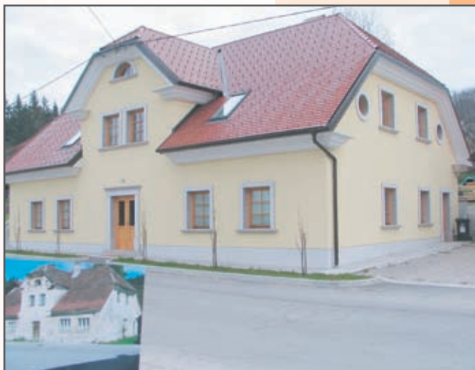
Spodaj levo hiša pred obnovo, zadaj obnovljena hiša
