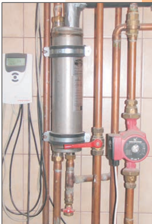
Zunanji prenosnik toplote omogoča ogrevanje prostorov z vakuumskimi SSE
