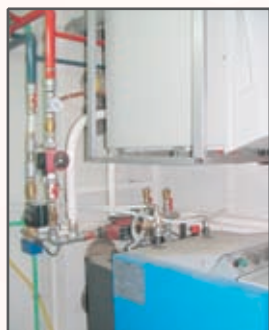
Spodaj kotel na polena, za njim »ekonomizator«, zgoraj kotel na nafto
