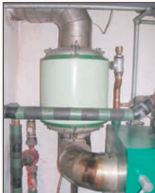
Ekonomizator odvzema iz dimnih plinov 80 – 100°C s pomočjo 60 litrov vode
