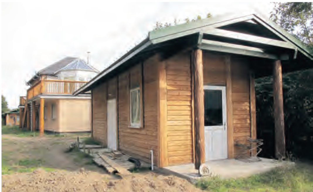
Slika 12 Kurilnica s kotlom na pelete za daljinsko ogrevanje nizkoenergijskih stavb v ozadju
