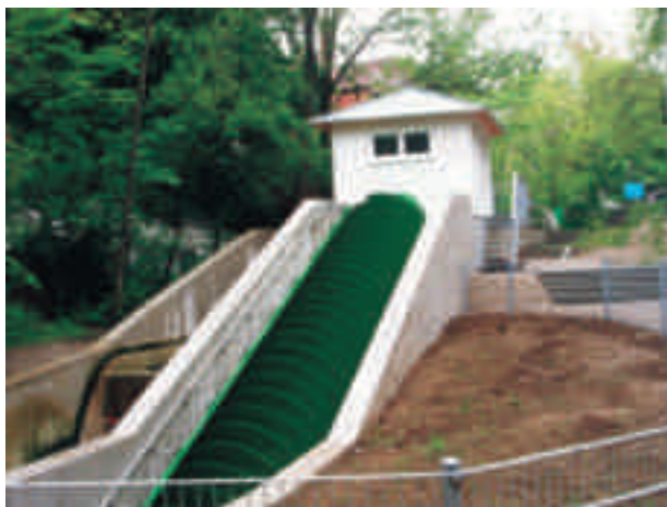
Slika 6 SH tip zahteva gradnjo stavbe, v kateri je strojni in električni del. Zaradi poplav in prepovedi gradnje novih objektov ta tip ni primeren za belokranjske reke
