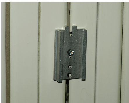
Montaža delilnika stroškov ogrevanja na radiator
