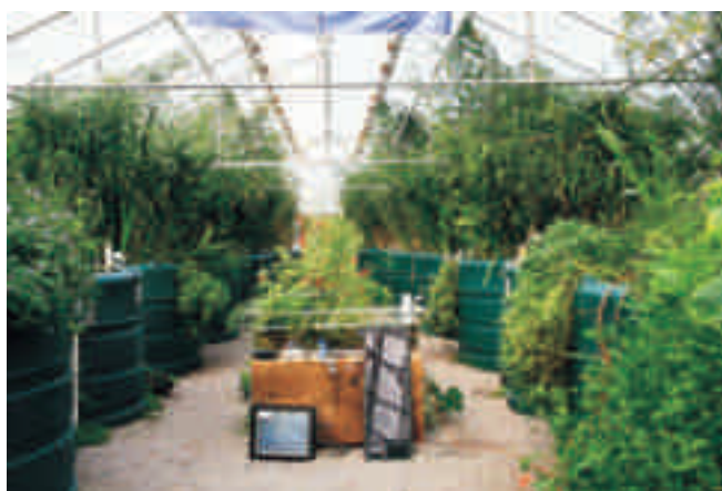
Slika 3 »Living machine« od znotraj, kjer vidimo dve liniji aeracijskih rezervoarjev
