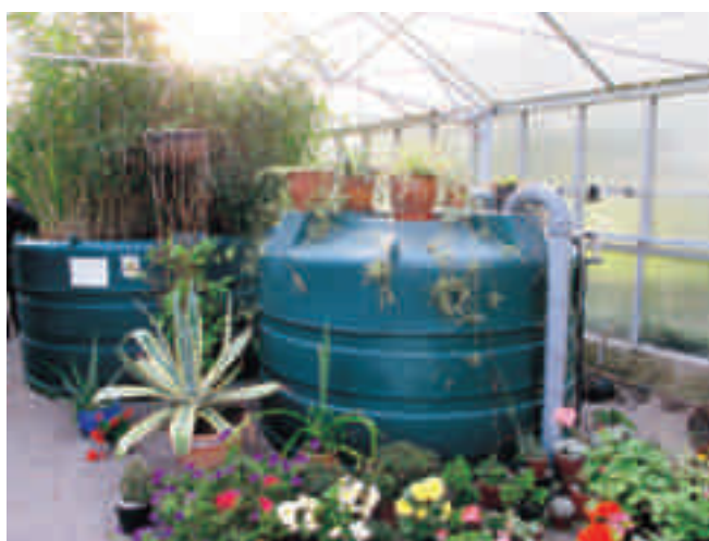
Slika 4 Zaprti aeracijski rezervoar, preko sive cevi se dovaja odpadna voda, zrak pa se vpahuje od spodaj
