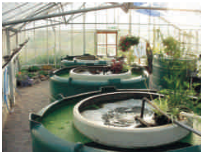
Slika 5 Filtrirni rezervoarji; odpadna voda priteka v prostor med zunanjim in notranjim obročem rezervoarja, v osrednji delu se vpihuje zrak, ki dviguje vodo, da kroži
