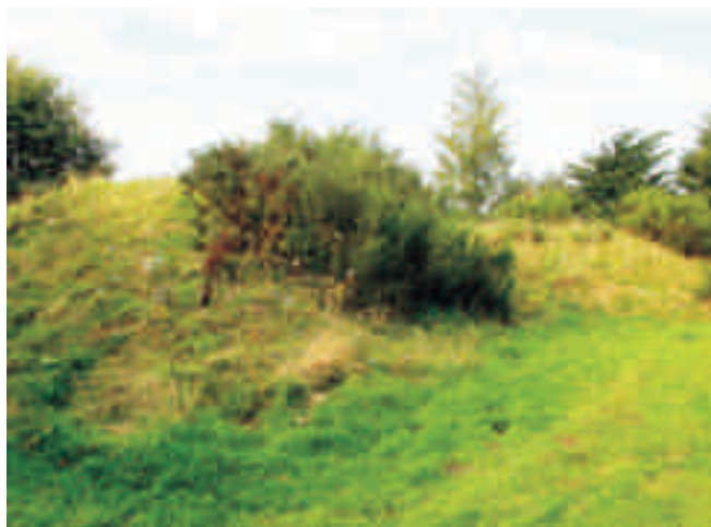
Slika 2 Anaerobni rezervoarji pred rastlinjakom so prekriti z zemljo in zatravljeni
