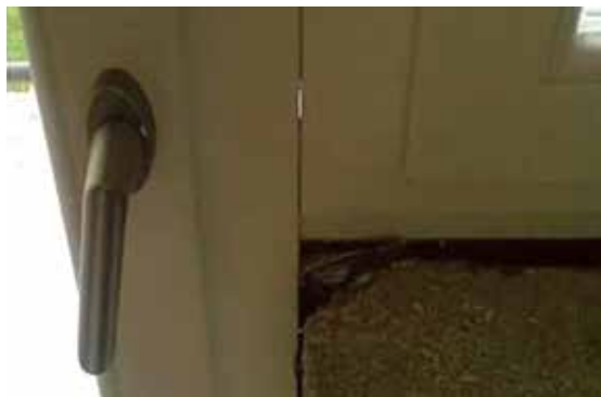
Stik med balkonskimi vrati in oknom ni tesnen, vidi se skozi!
