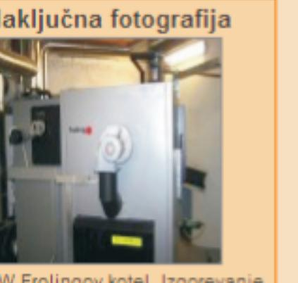
220 kW Frolingov kotel. Izgrevanje je avtomatsko kmiljeno, zato je kotel opremljen z ventilatorjem, ki mu po potrebi dovaja svež zrak.
