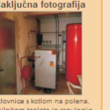
Kotlovnica s kotli na polen, hranilnikom toplote in regulacijo ogrevalnega in solarnega sistema.
