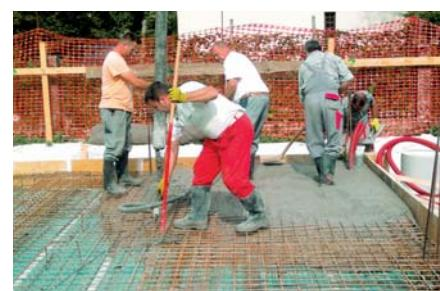
Postopoma odstranjujemo zaščitno folijo hidroizolacije in plošče FIBRANxps SEISMIC polagamo previdno in natančno na lepljivo hidroizolacijsko površino, zaradi močne lepljivosti so popravki zelo težavi. Pred montažo armature morebitne špranje zatesnimo s PU-peno. Na vrsti sta polaganje armature z distančniki in betoniranje.
