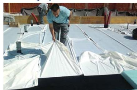
Pred nameščanjem podložnega betona in prvega sloja toplotne izolacije FIBRANxps posebno pozornost namenimo inštalacijam. Na natančno položeni prvi sloj toplotne izolacije FIBRANxps ustrezne debeline nalepimo samolepilno hidroizolacijo. Na nalepljeni sloj dvosransko samolepilne hidroizolacije postavimo opaž temeljne plošče.
