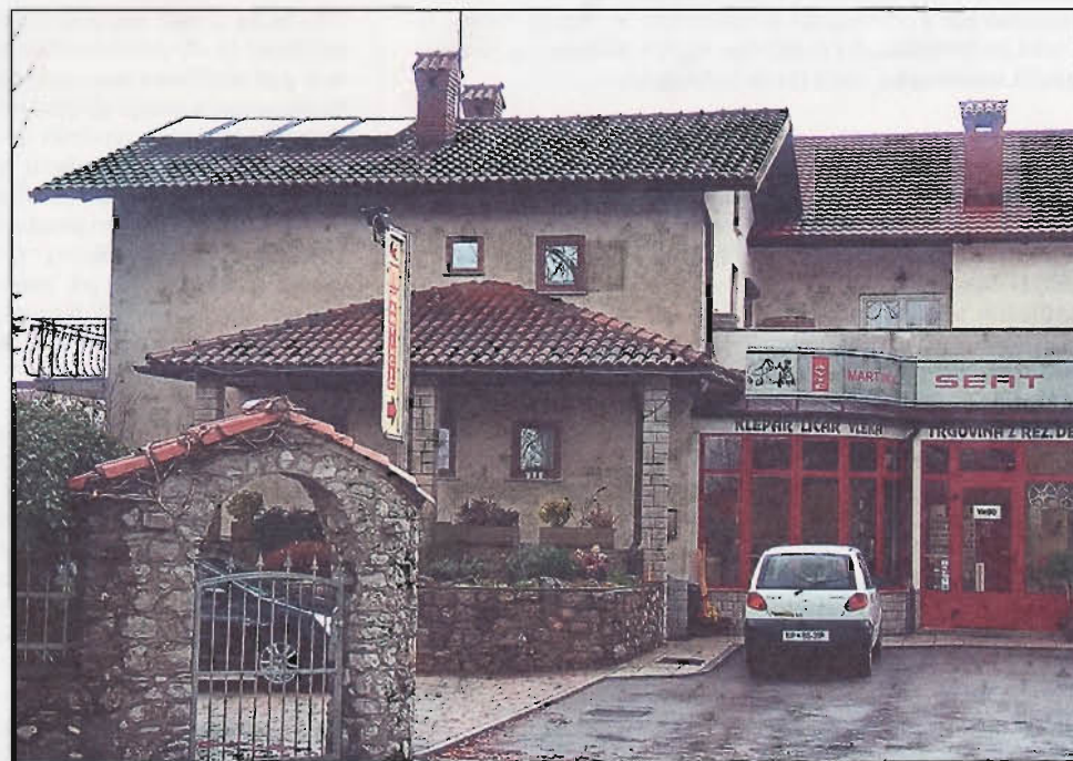
Franc Martinčič je na streho vgradil štiri sončne kolektorje, s katerimi ogreva vso sanitarno vodo
