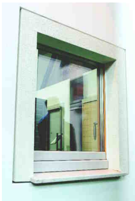
SISTEM VGRADNJE S SLEPIM OKVIRJEM M SORA
