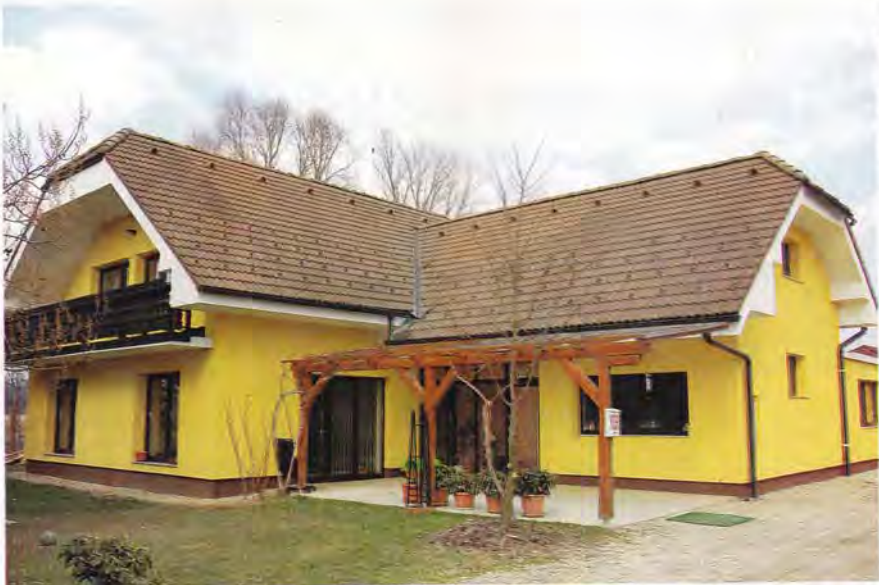
Pred spremembo načina ogrevanja so morali energetsko obnoviti celotno hišo: zamenjati stavbno pohištvo ter narediti dodatno izolacijo strehe in fasade.
